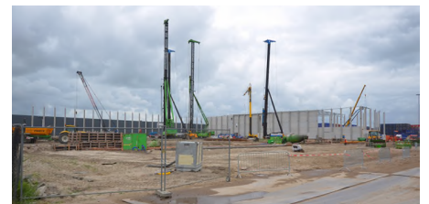
Voor de fundering moeten palen 40 meter de grond in
