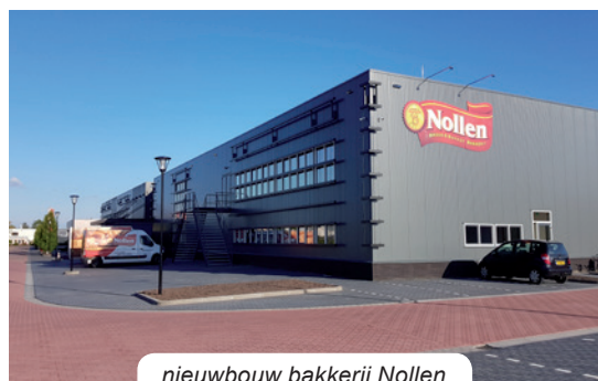
nieuwbouw bakkerij Nollen
