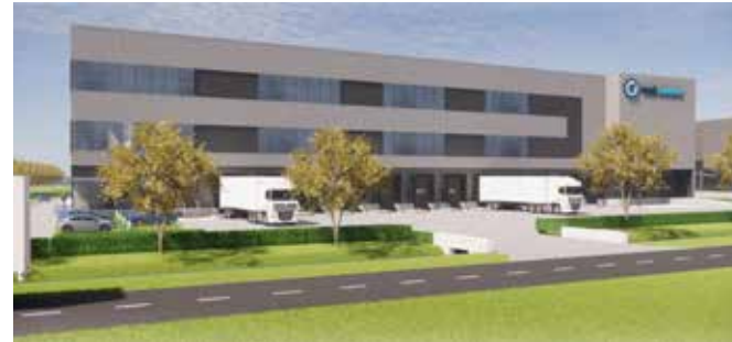
Een deel van de koelcellen is al in gebruik, terwijl Van Mierlo de rest van het gebouw afbouwt.
